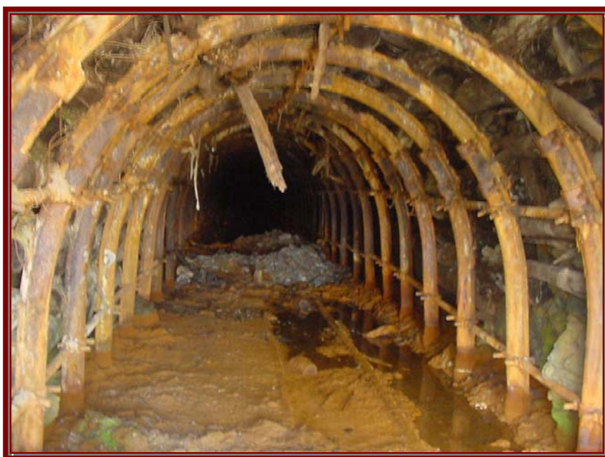
Foto 2 – Galeria da Mina 135
