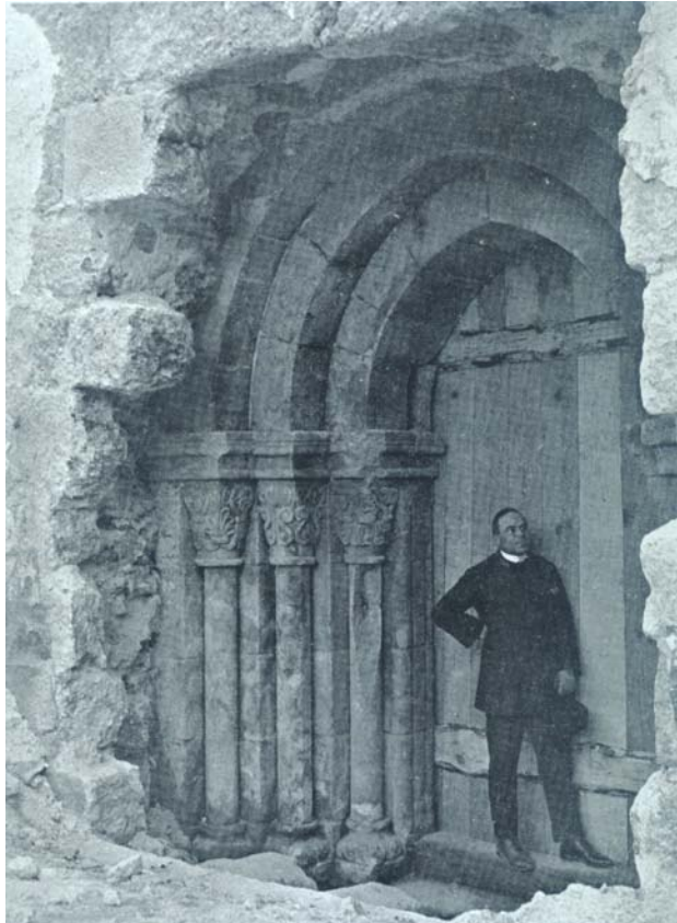
Ilustração 15 – Aspecto de Remoção da Parede sul dos Claustros com o Pe. Manuel Gomes de Castro
