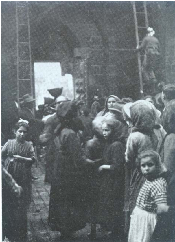
Ilustração 13 – Rescaldo do Incêndio que assolou a Igreja, Marques de Abreu
