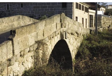
4. Na Ponte de Espindo a largura do vão obrigou à elevação do arco e à colocação do tabuleiro em cavalete.
