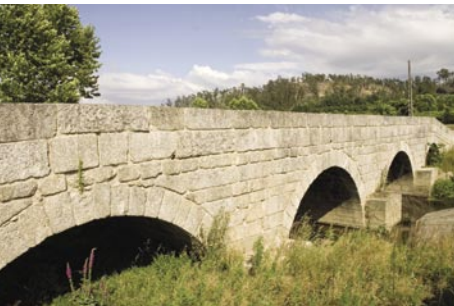
3. A jusante da Ponte de Vilela os talhamares são quadrangulares.
