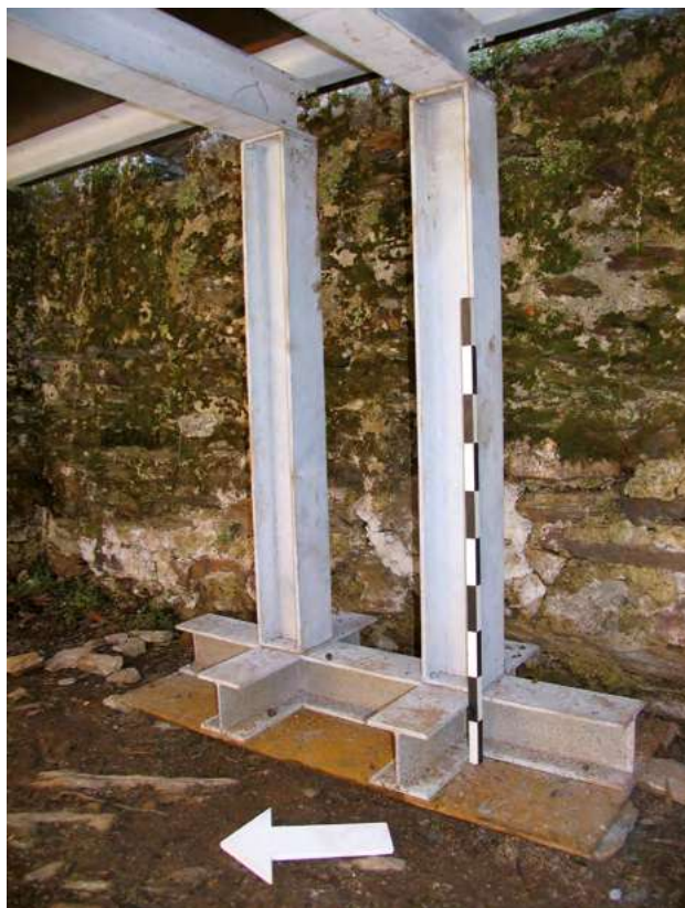
Estrutura do varandim da Torre.
