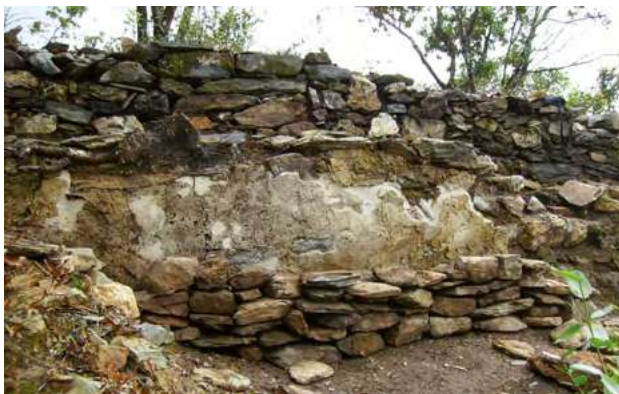
Início da construção do muro de proteção.
