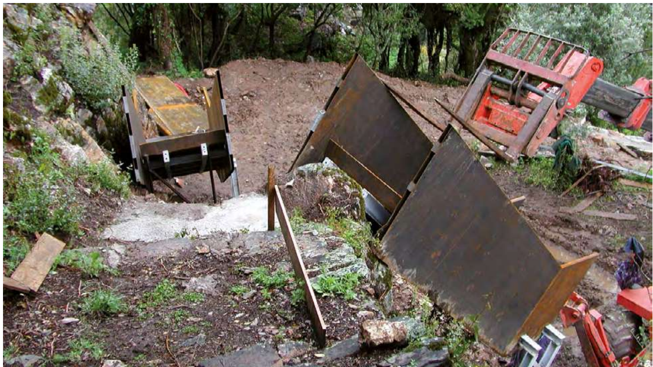
Acompanhamento da obra, aferindo in loco a estrutura projetada.
