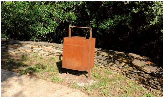
Muro de contenção de terras com altura para assento e mobiliário urbano.
