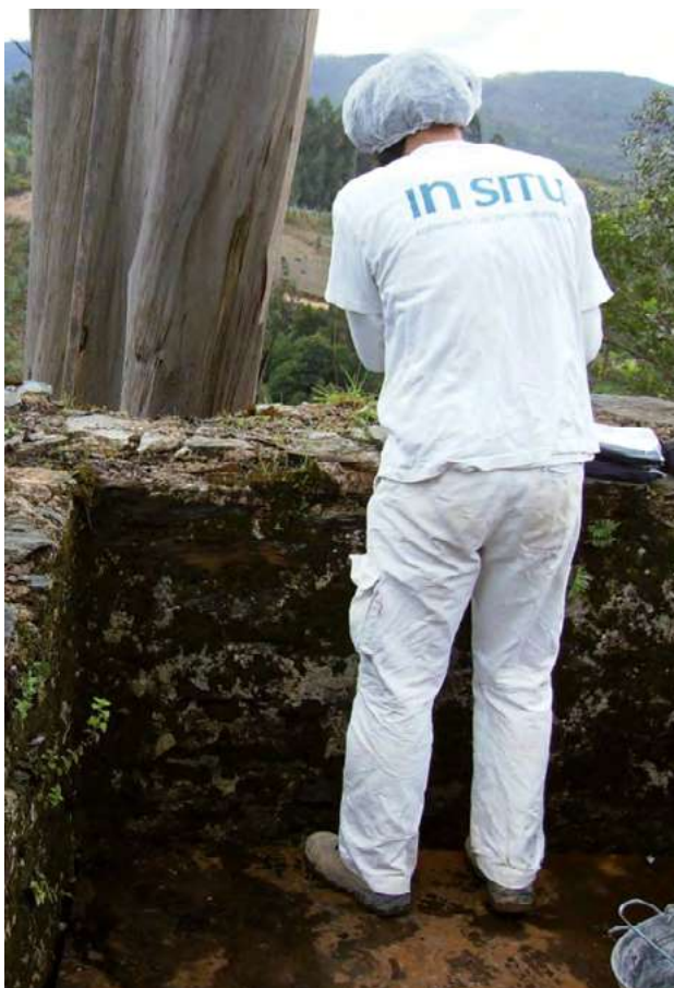
Limpeza manual dos panos da Torre do Castelo de Aguiar de Sousa.
