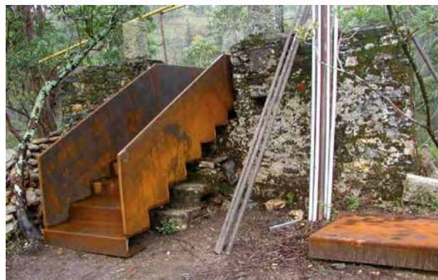
Estrutura de acesso ao varandim.
