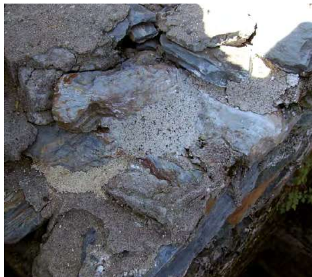
Pormenor dos testes de argamassas.
