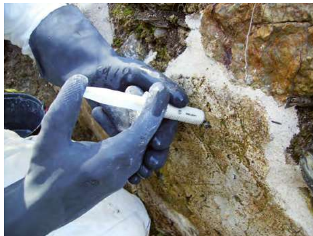
Pormenor da injeção de uma calda para consolidação do reboco.
