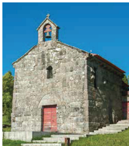
Igreja de Vila Verde (Felgueiras). Fachadas ocidental e sul.
