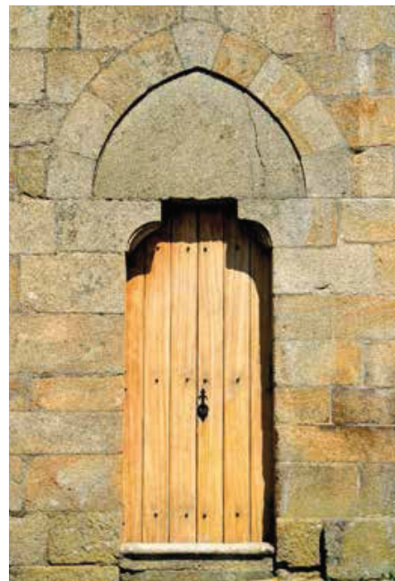
Fachada sul. Nave. Portal.
