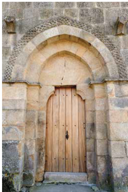
Fachada norte. Nave. Portal.
