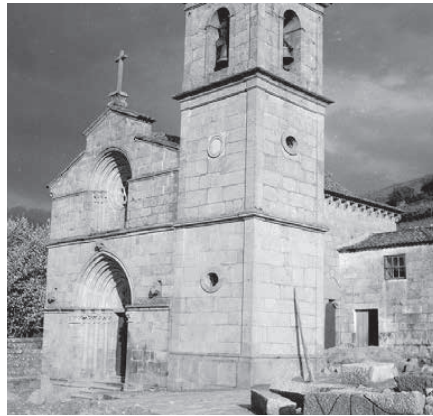
Fachada sul. “Sala das Almas” em 1955. Fonte: arquivo IHRU.
