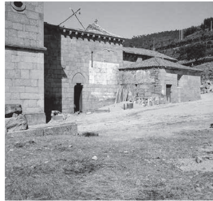
Fachada sul. “Sala das Almas” em 1966. Fonte: arquivo IHRU.
