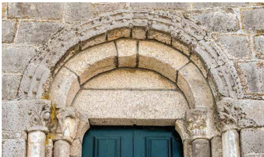
Fachada norte. Nave. Portal. Tímpano, arquivoltas e capitéis.
