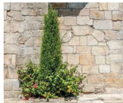
Fachada sul. Nave. Cicatrizes de arcos.
