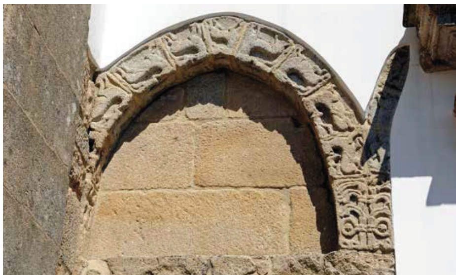
Igreja. Fachada ocidental. Arcadas cegas.
