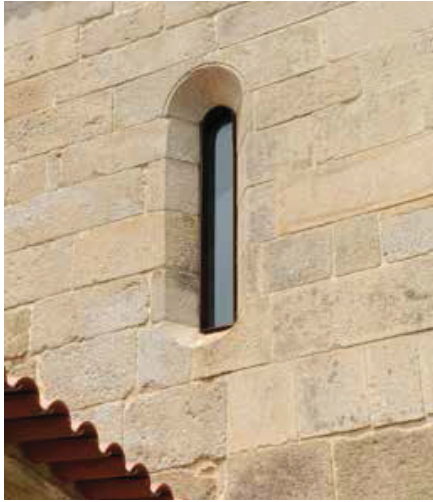
Igreja. Fachada sul. Nave. Fresta. Vista exterior.
