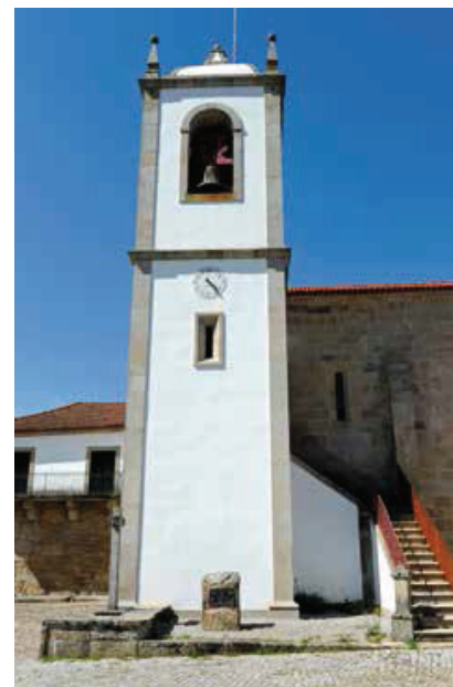
Fachada sul. Torre sineira.
