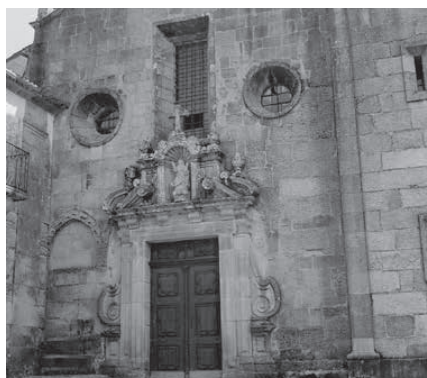
Fachada ocidental antes das intervenções da década de 1990. Fonte: arquivo IHRU.
