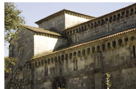
6. A igreja apresenta parcelas de diferentes épocas. Na fachada norte há frisos reaproveitados de uma construção românica mais antiga e de um templo pré-românico.
