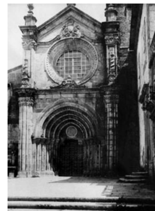
27. Fachada ocidental antes da intervenção da DGEMN.
