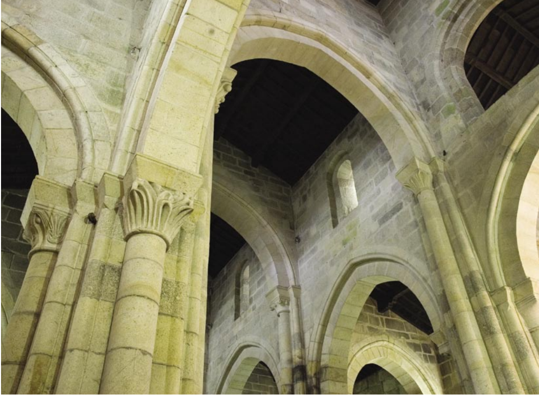
11. Cobertura do transepto da nave central e da nave lateral. Os arcos-diafragma alternam com cobertura em madeira.
