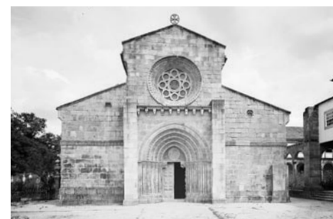
32. Fachada ocidental depois da intervenção da DGEMN.
