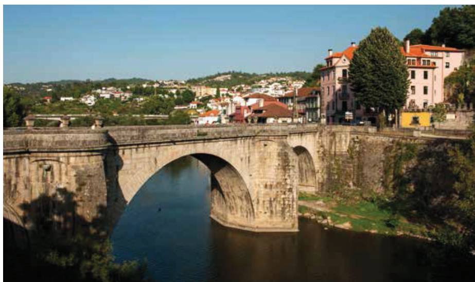
Ponte de São Gonçalo (Amarante). Vista de jusante.
