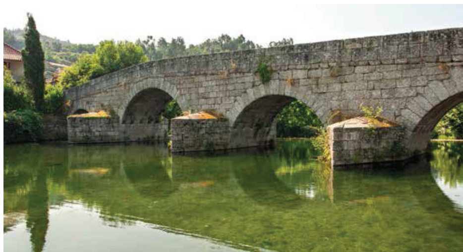
Vista de montante.
