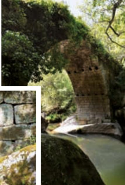
comum nas travessias góticas – colocamos perante uma cronologia mais tardia. Ainda que esteja fora do leito de cheia, foi adossado à Ponte um talha-mar, encostado à face este da estrutura, e junto do qual foi aberto um vão de formato sensivelmente retangular, que permite o escoamento de água em cheias excêntricas ou a condução de certo rego (para abastecimento de moinho ou lima de terras).
