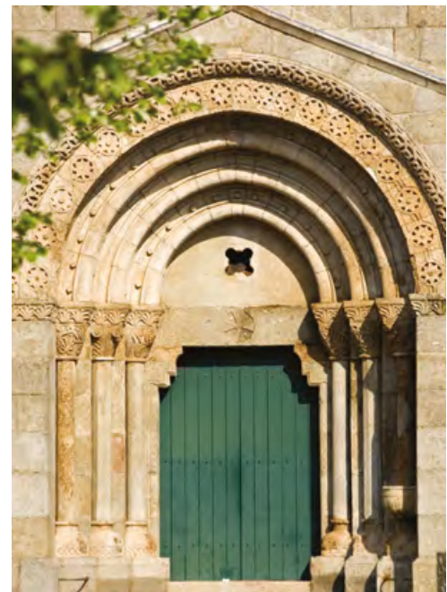
13. O portal ocidental da igreja românica é entendido como Porta do Céu . Igreja de São Vicente de Sousa.
