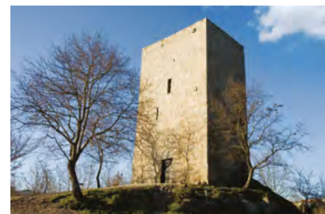
23. Consagrando antigas senhorias, as torres constituem um meio muito expressivo da forma de ocupar o território. Torre de Vilar.
