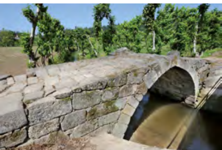
Ponte da Veiga (Lousada). Vista de montante.
