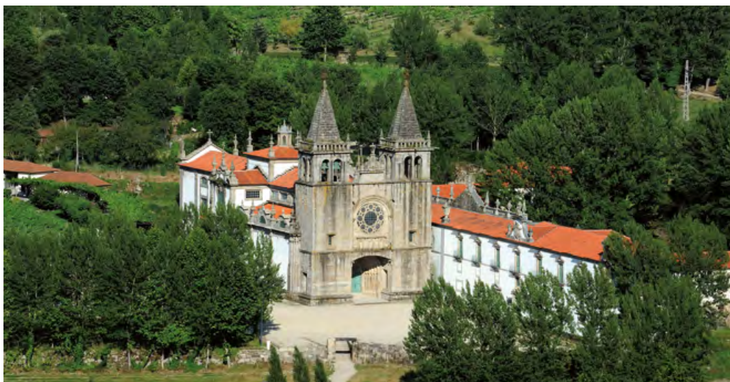
Mosteiro de Pombeiro (Felgueiras). Vista geral.
