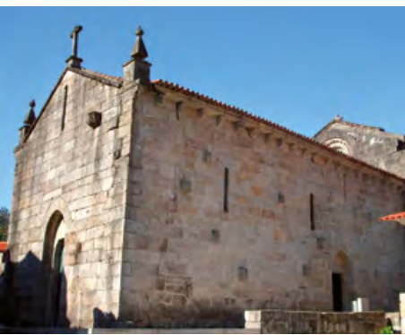
Mosteiro de Ermelo (Arcos de Valdevez). Fachadas ocidental e sul.
