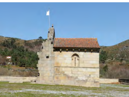
Capela de Fandinhães (Marco de Canaveses). Fachada sul.
