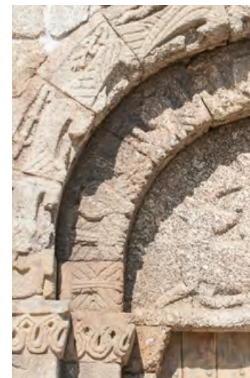
Mosteiro de Travanca (Amarante). Torre. Portal. Aduelas.
