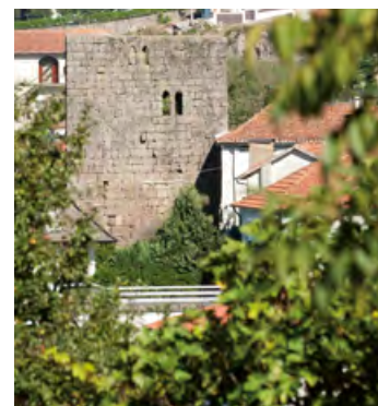
Torre dos Alcoforados (Paredes) antes das intervenções da Rota do Românico (2014). Fachada ocidental.
