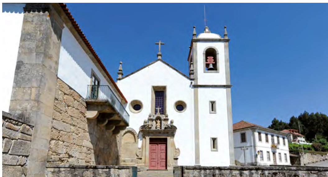
Mosteiro de Vila Boa do Bispo (Marco de Canaveses), Fachada ocidental.
