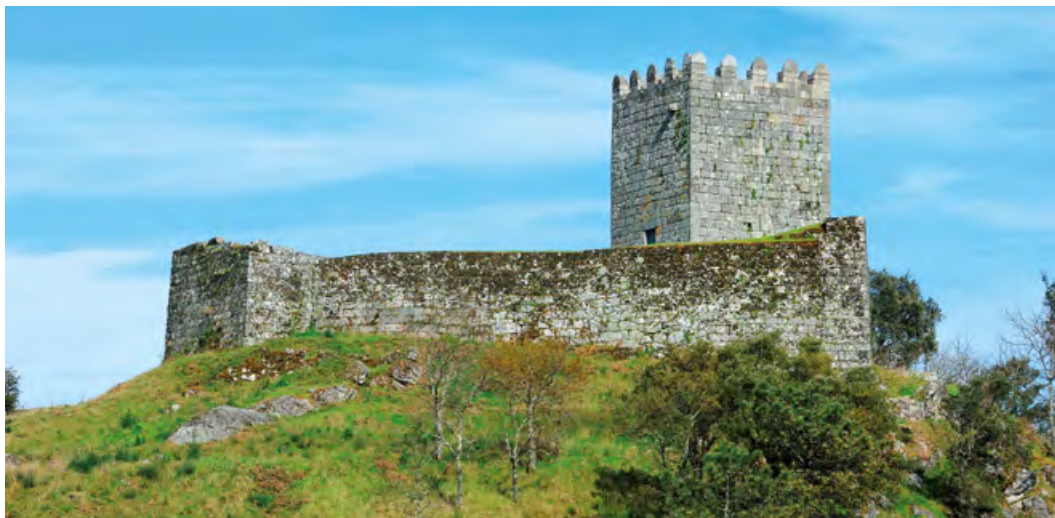
Castelo de Arnoia (Celorico de Basto). Vista de ocidente.
