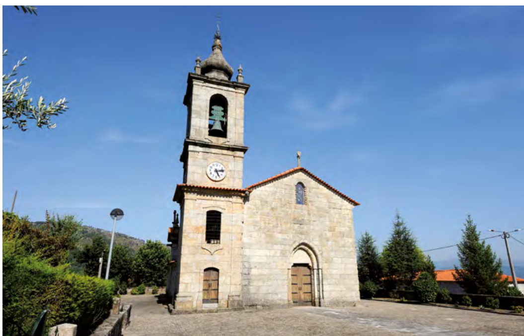
Igreja de Ribas (Celorico de Basto). Fachada ocidental.
