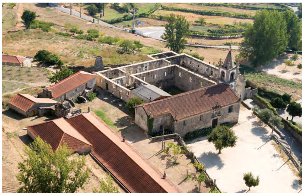
Mosteiro de Ancede (Baião). Vista aérea.
