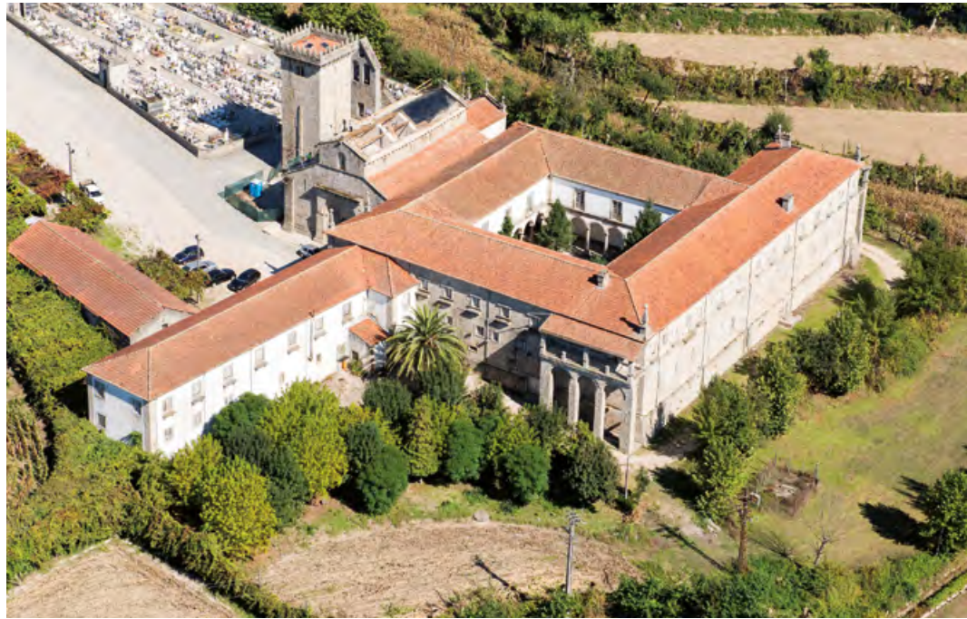
Mosteiro de Travanca (Amarante) durante as intervenções da Rota do Românico (2013). Vista aérea.
