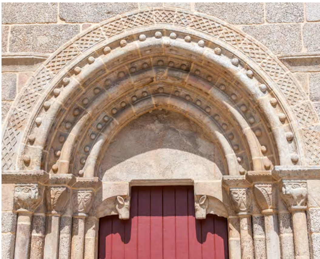
Igreja de Tabuado (Marco de Canaveses). Fachada ocidental. Portal.
