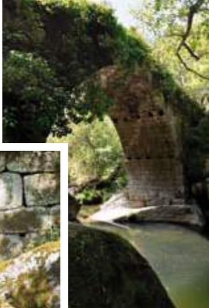
Bien qu'il se trouve hors du lit de crue, un arrière-bec est adossé au Pont, du côté oriental de cette structure, près duquel est ouverte une baie de forme presque rectangulaire, qui permet l'écoulement de l'eau lors des grandes crues ou la conduite de l'eau jusqu'à une rigole (pour l'approvisionnement d'un moulin ou d'un terrain calcaire).
